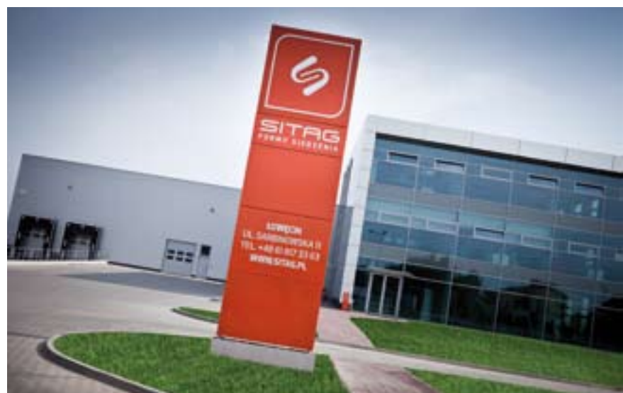
NOWA SIEDZIBA SITAG FORMY SIEDZENIA POWSTAŁA W SWARZĘDZU – ŁOWĘCINIE. INTENSYWNE PRACE BUDOWLANE ZAJĘŁY 10 MIESIĘCY.
